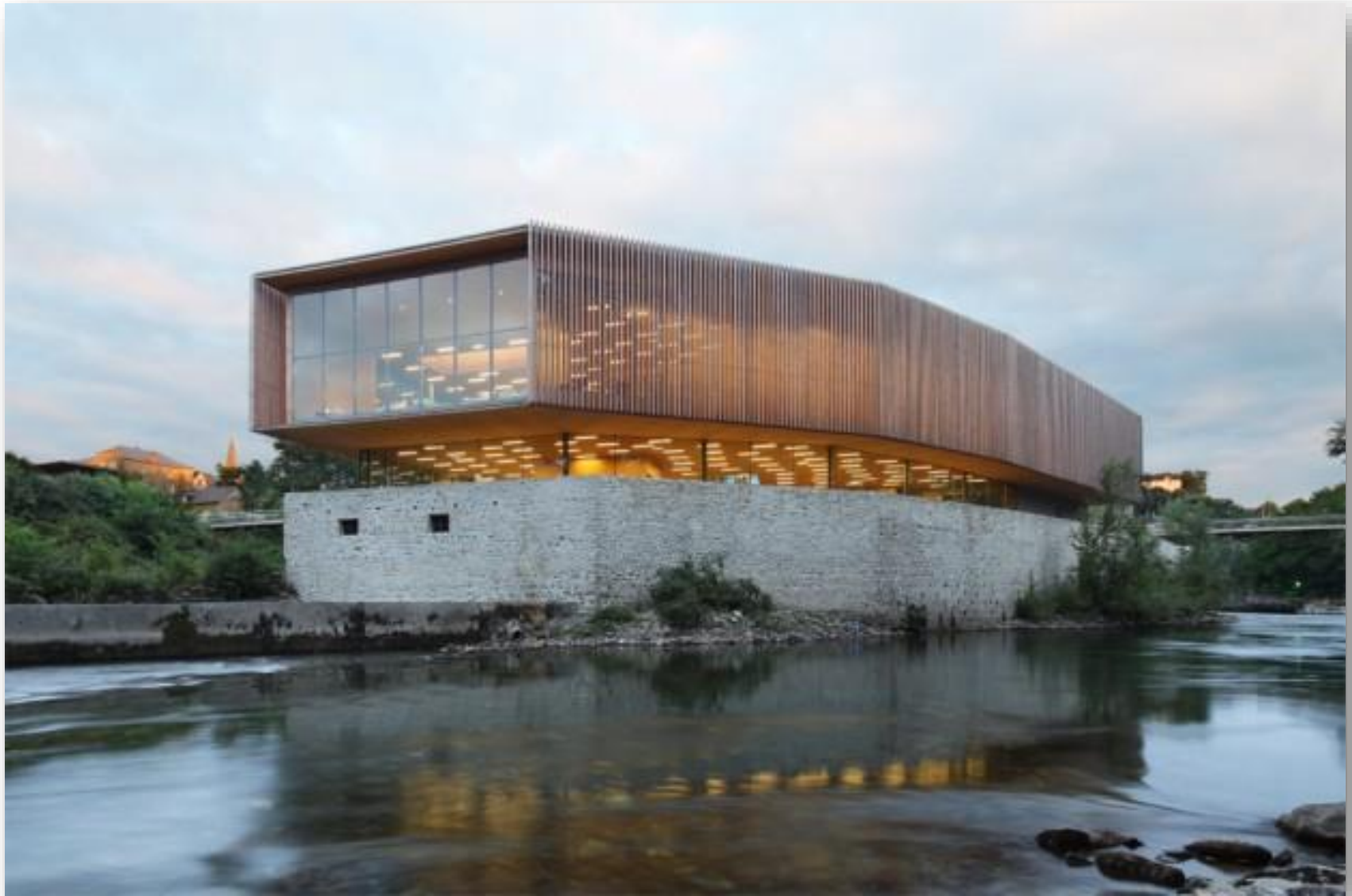
Médiathèque intercommunale, Oloron-Sainte-Marie par Agence Pascale Guédot (Pyrénées-Atlantiques)
