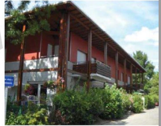
Reconversion bâtiment d'activité en logements
