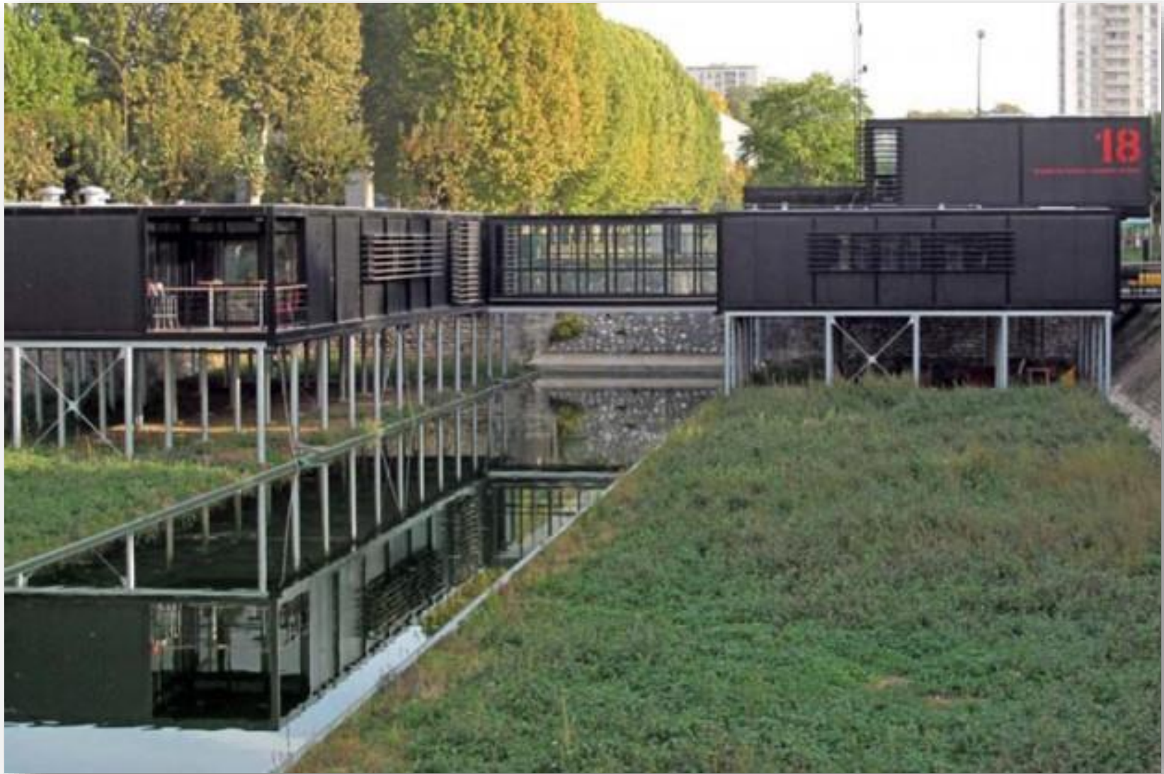
Centre de secours modulaire, Joinville-le-Pont par Agence Roquelaure & associés (Val-de-Marne)
