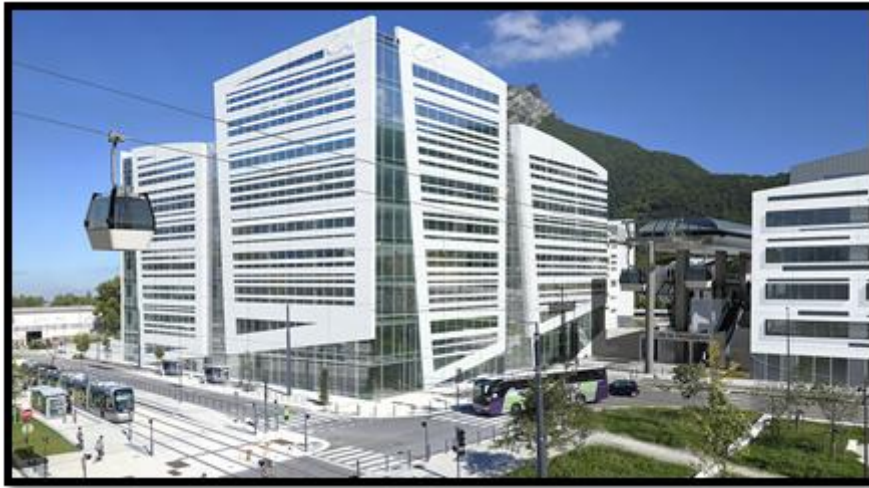
Photo 5 : Le projet de métro-câble à Grenoble à l'horizon 2021, Source : La Métropole
